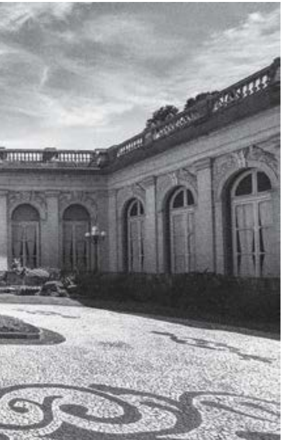
Palácio Piratini, sede do governo gaúcho: aposta está em PPPs e concessões para avançar na infraestrutura do estado
