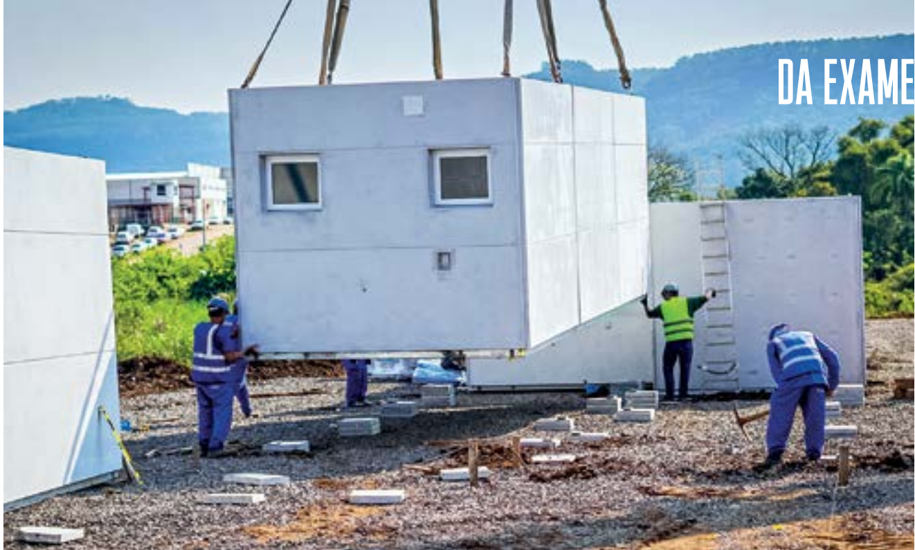
Reconstrução de casas no Rio Grande do Sul: depois de passar por uma tragédia climática em 2024, o estado se reconstrói de forma sustentável e atrai investimentos privados
