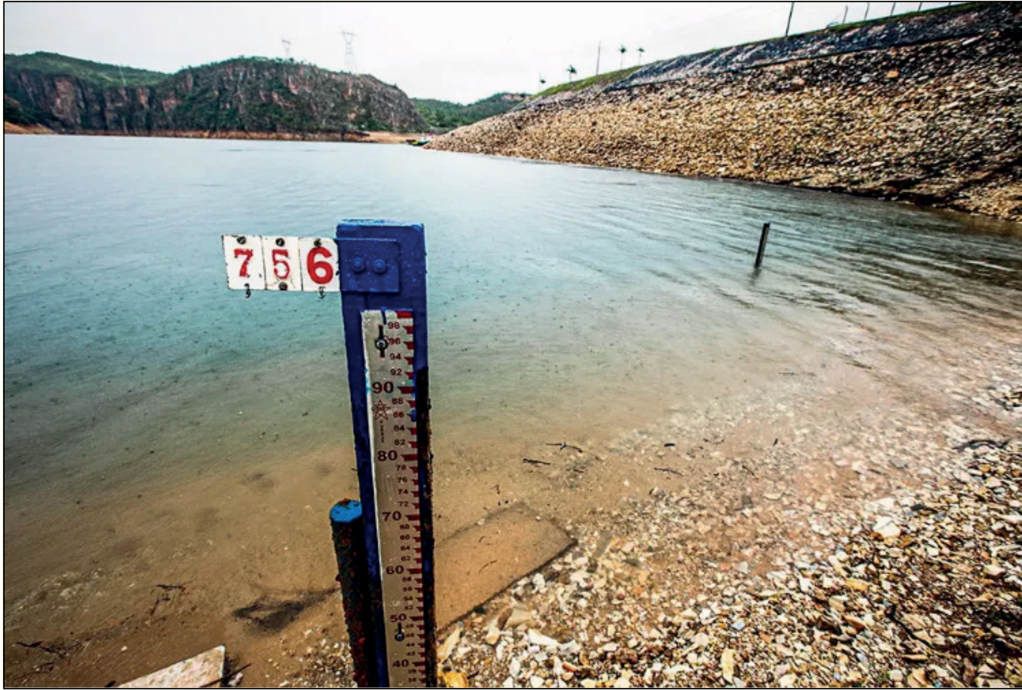
Instrumento para medição do nível d'água na barragem da usina hidrelétrica de Furnas, em São José da Barra (MG)
